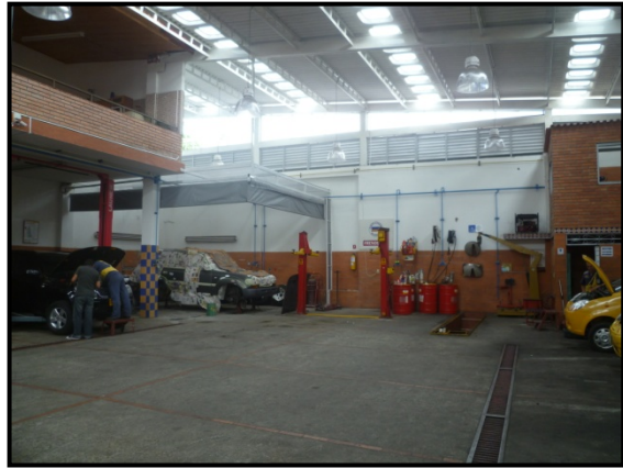
Fotografía 16. Luminaria con lámpara de sodio
