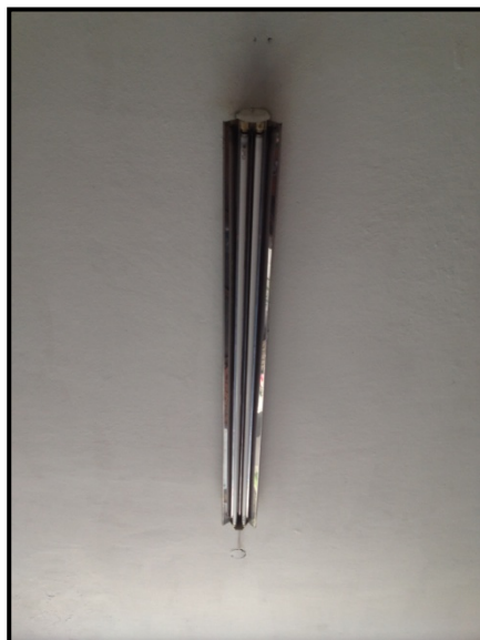
Fotografía 15. Luminaria con lámpara tipo T8 y superficie reflectiva.
