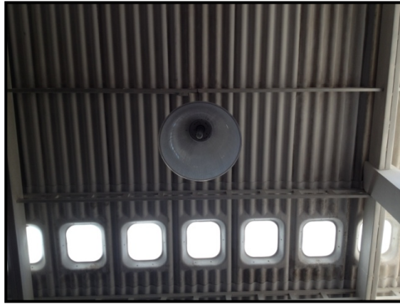
Fotografía 16. Luminaria con lámpara de sodio
