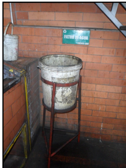
Fotografía 12. Sistema de filtro utilizado para remover sólidos y grasas de los residuos líquidos acuosos generados en el lavado de piezas de los vehículos.
