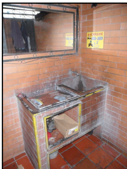
Fotografías 5 a 7. Llaves terminales instaladas en los puntos de agua utilizados por los empleados de la empresa.
